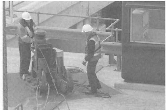
ドーバー港のウインチ付きの係船装置
